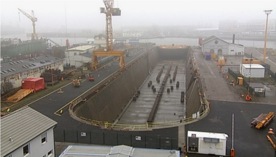
Aus der Lloyd-Werft soll ein Gewerbepark werden.
