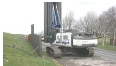
25 Meter tief werden die Stahlwände in den Erdboden getrieben.
