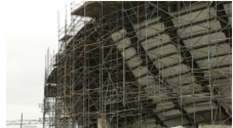
Baustelle Klimahaus Bremerhaven
