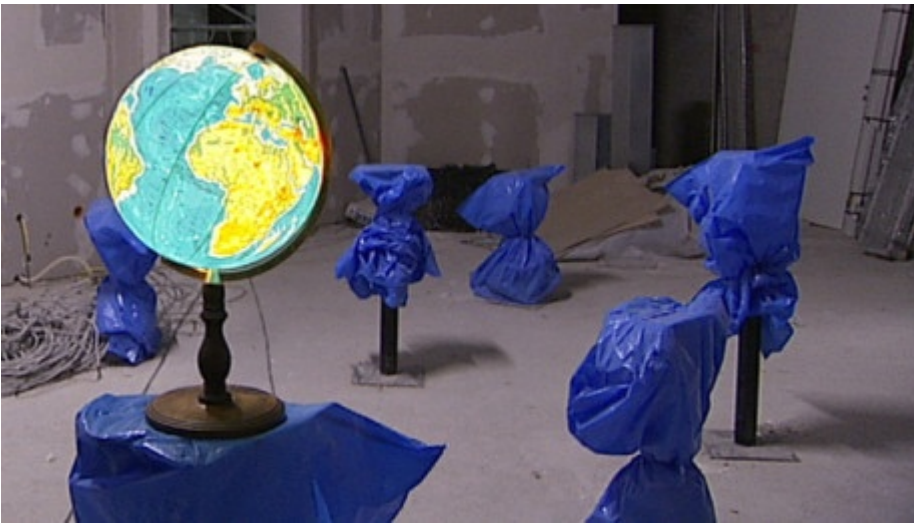
Baustelle Klimahaus Bremerhaven
