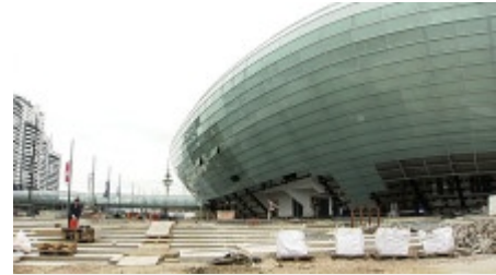
4.700 handgefertigte Glasscheiben müssen auf den Stahlkörper gepuzzelt werden.
