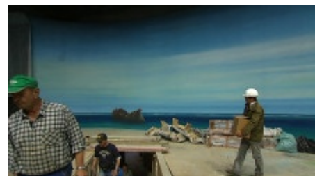
Die letzten Bauarbeiten im Klimahaus
