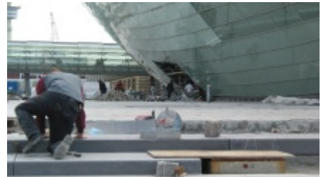
24 Stunden vor der VIP- Eröffnung wird noch immer gehämmert und gebohrt.
